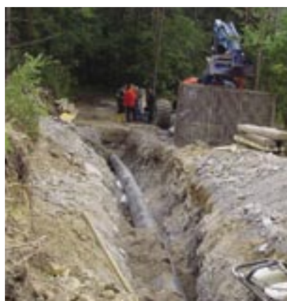
Grabungsarbeiten für Ableitungskanal zum Inn (Druckrohrleitung für Kraftwerk) Archivaufnahmen 2003
