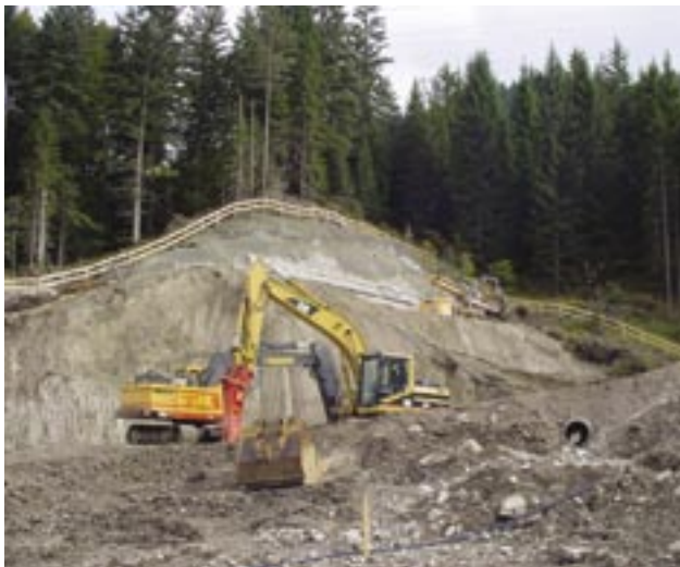
Baugrube für Abwasserreinigungsanlage
