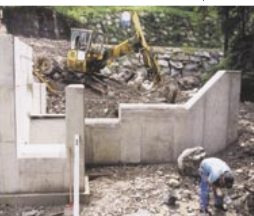
Grabungsarbeiten für Ableitungskanal zum Inn (Druckrohrleitung für Kraftwerk) Archivaufnahmen 2003
